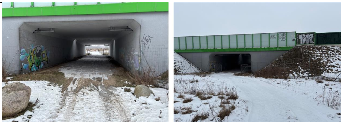
Przejście dla zwierząt na autostradzie A1 – stan na 5 lutego 2026 r.
