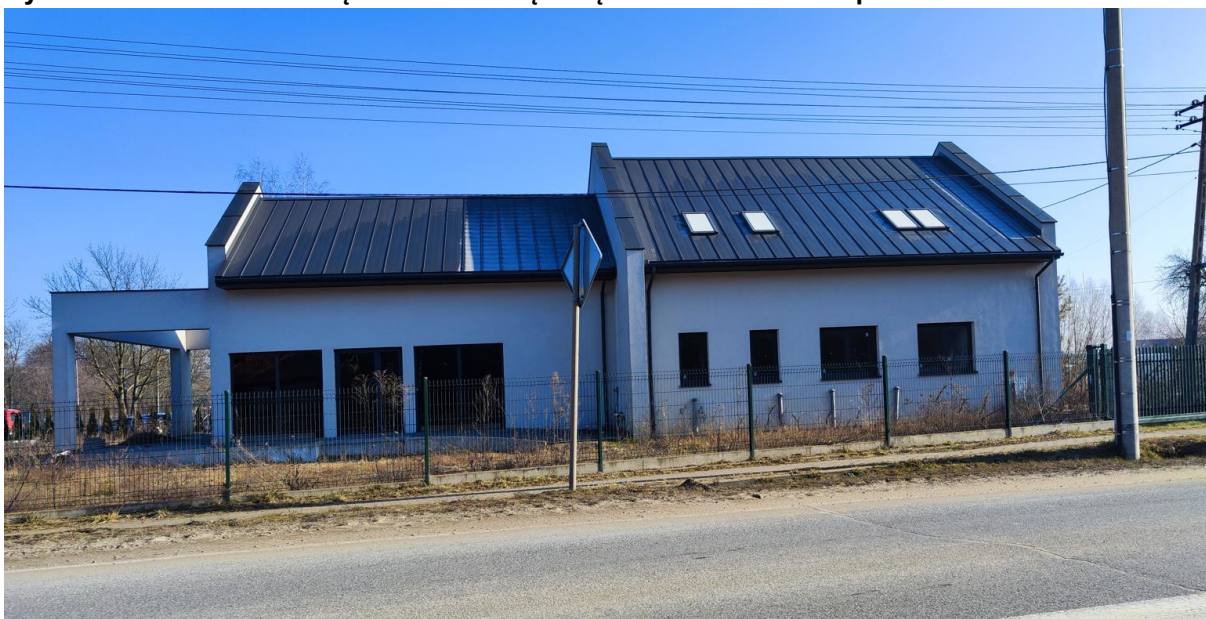
Ryc. 9. Widok na zabudowę zlokalizowaną w sąsiedztwie obszaru opracowania
