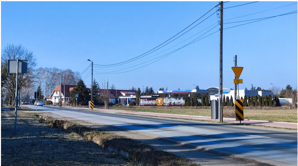
Ryc. 13. Widok na drogę powiatową nr 2911E, zlokalizowaną w sąsiedztwie obszaru opracowania
