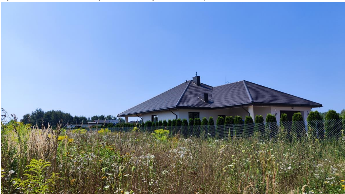
Ryc. 6. Widok na zabudowę zlokalizowaną w obszarze opracowania
