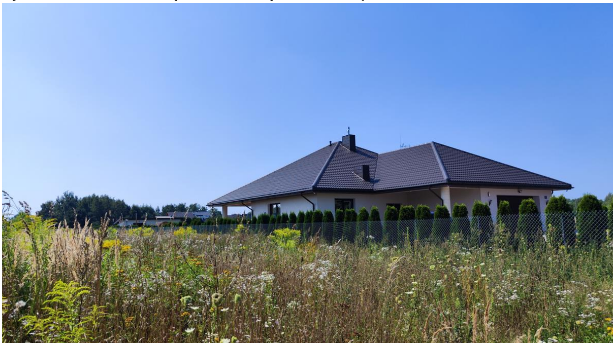
Ryc. 6. Widok na zabudowę zlokalizowaną w obszarze opracowania
